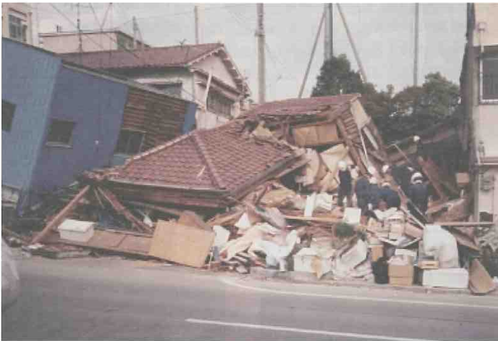
阪神淡路大震災のときの被災写真です
